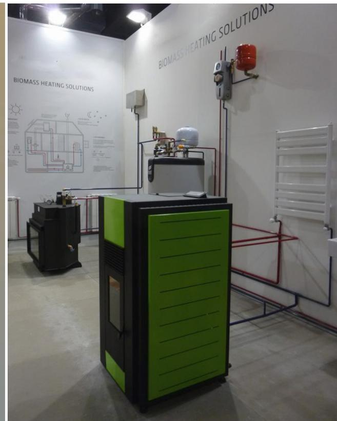
**Il generatore di calore a biomassa non fa altro che sostituire la tradizionale caldaia a combustibile fossile, scaldando l'acqua in un accumulo per poi redistribuire il calore necessario ai terminali tramite tubazioni**
