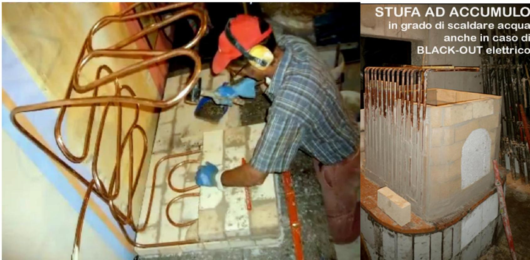
**La produzione di acqua calda è garantita senza pompe e meccanismi elettrici con la sola circolazione naturale**
